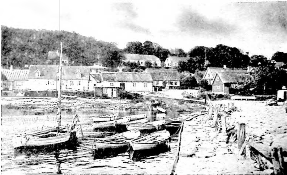
Likformiga byggnadskroppar, tak och fönster ge fasthet åt »stadsbilden». Arild, Skåne.
