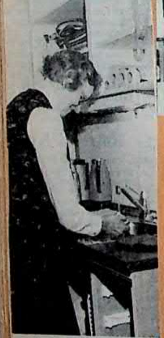
Märta Karlsson skötte disken och där måste framhållas, att man nu fått vatten o. avlopp i köket på andra våningen, något som var efterlängtat.
