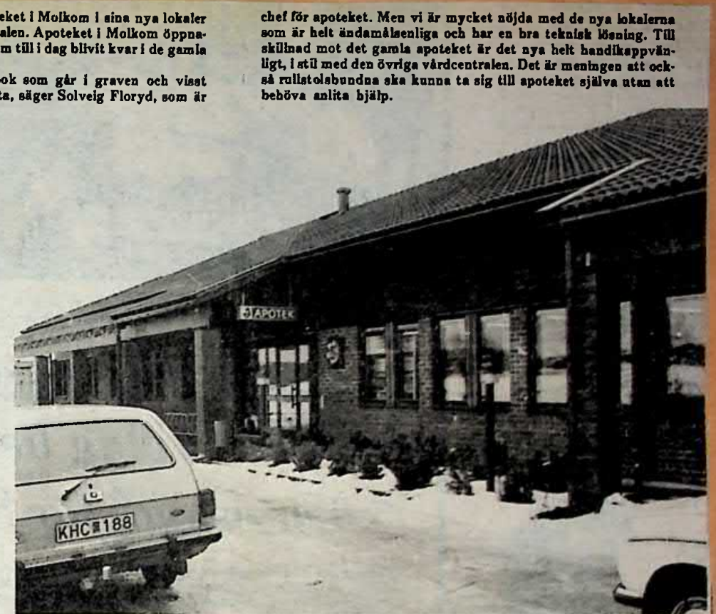
De nya apotekslokalerna i den nya vårdcentralen är som vårdcentralen i övrigt helt handikappvänligt byggd utan trottoarer, med automatiska dörröppnare och utan trösklar.
