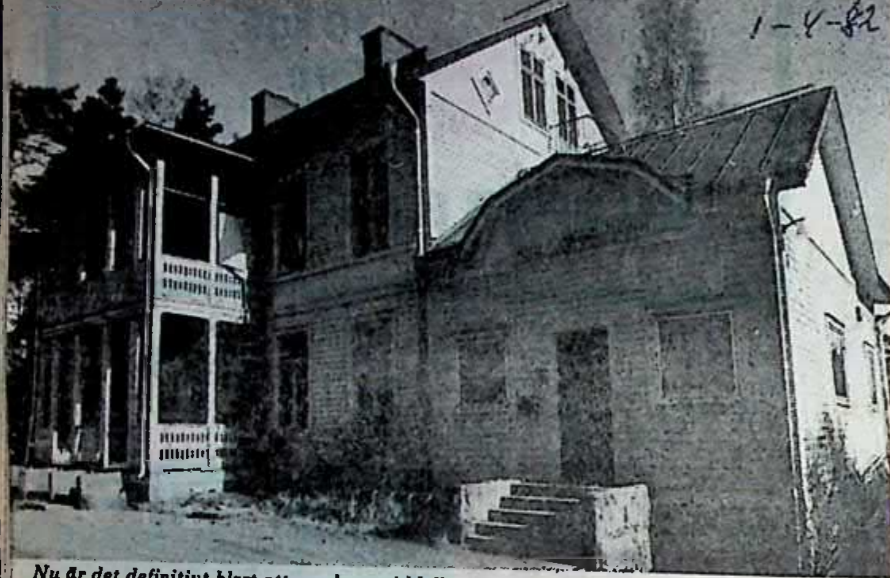
Nu är det definitivt klart att ungdomen i Molkom kommer att få en ny och fin fritidsgård i f.d. Apoteksvillan. Någon gång under våren är byggnaden färdig.
