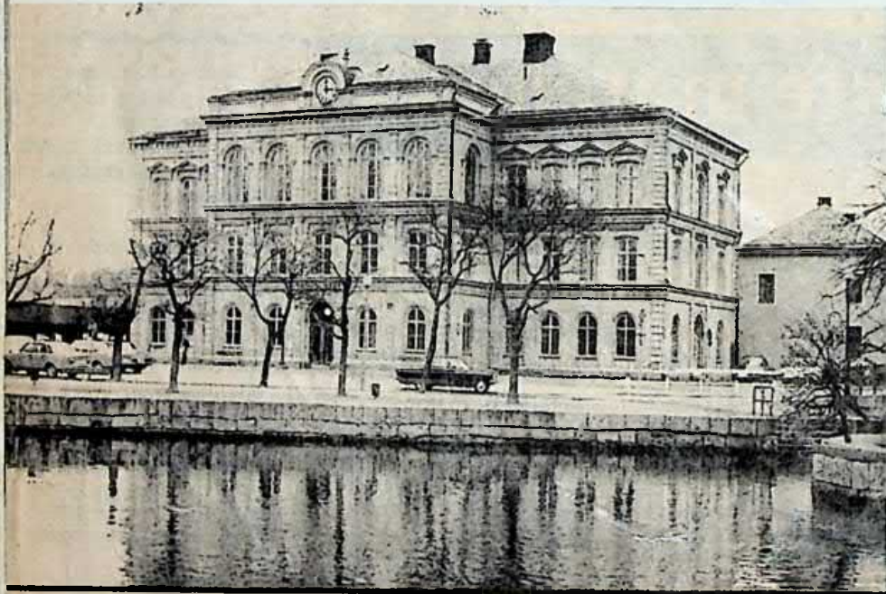
Stadshotellet i Filipstad vars öde beseglades på torsdagskvällen då kommunfullmäktige tog det slutgiltiga rivningsbeslutet.
