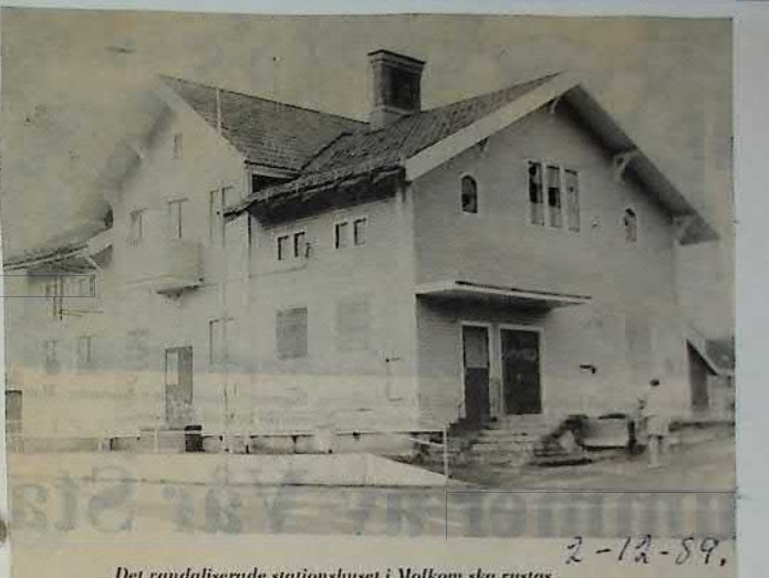
Det candaliserade stationshuset i Molkom ska rustas. 2-12-89.
