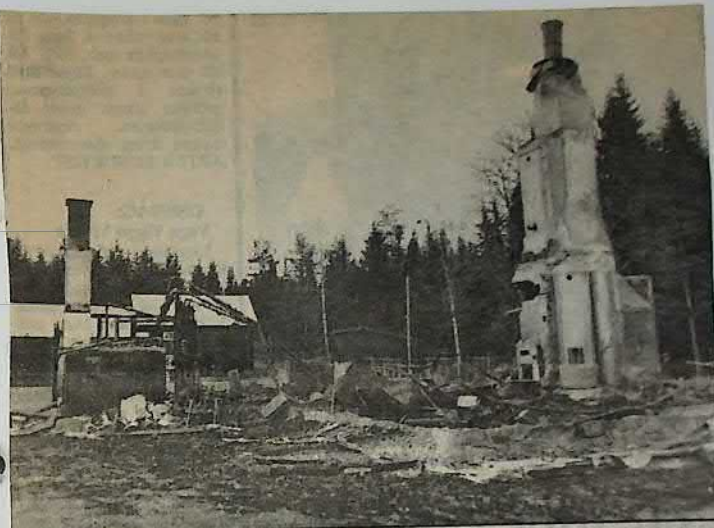
Boningshuset vid Bränningarna utanför Molkom var helt ödelagt efter söndagskvällens häftiga brand. 21-4-91.
