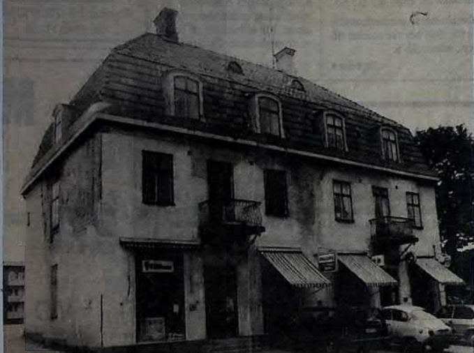
I det här området ska 50 nya lägenheter byggas. Storgatan 9 som idag ägs av HSB, kommer att rivas så småningom. Hyresgästerna är uppsagda från och med oktober i år. 3-6-86.
