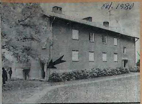
Det var genom ena gaveldörren (vid pilen) som rökgranaten kastades in i Nya elevhemmet. Där sov sjutton ungdomar. Samtliga kom snabbt ut ur den rökfyllda byggnaden.
