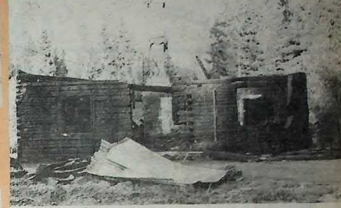
Här ses återstoden av den brunna fastigheten i Tallåsen. Timmerväggarna står kvar som ett förkolnat skal omkring murstocken. 7-6-79. GRHSA.
