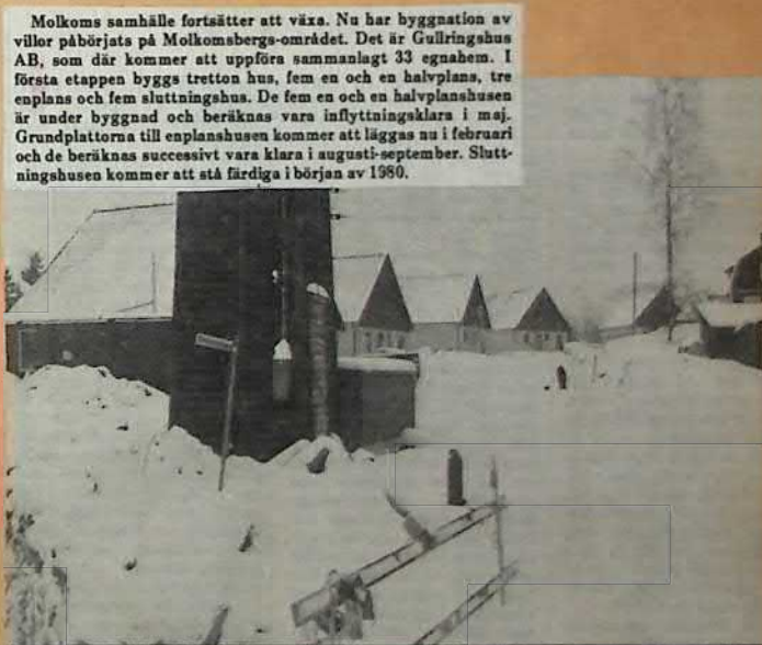
Den här bilden visar Molkombergsområdet med de fem egnahem som är under uppförande. Längst fram till vänster grävs för vatten och avlopp samt förbereds gaturbeten. Transformatorhuset skall så småningom försvinna ur bilden. 10-2-79
