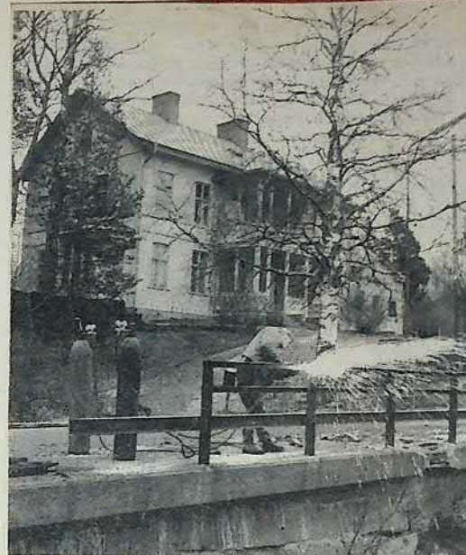
Rivningen av apoteksbron har börjat, här svetsas räcken bort.
