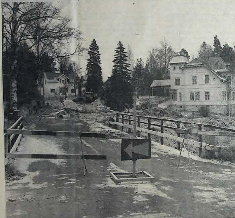
Vy från vägbygget från järnvägsstationen till Tennisvägen. Här vägen vid apoteket.
