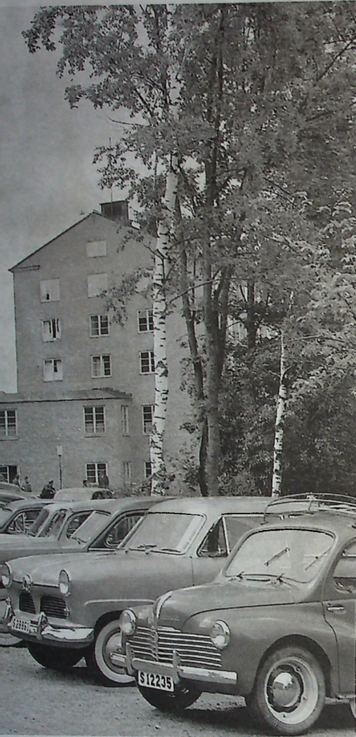
Bakom de stora fönstren en trappa upp låg stora operationssalen.
