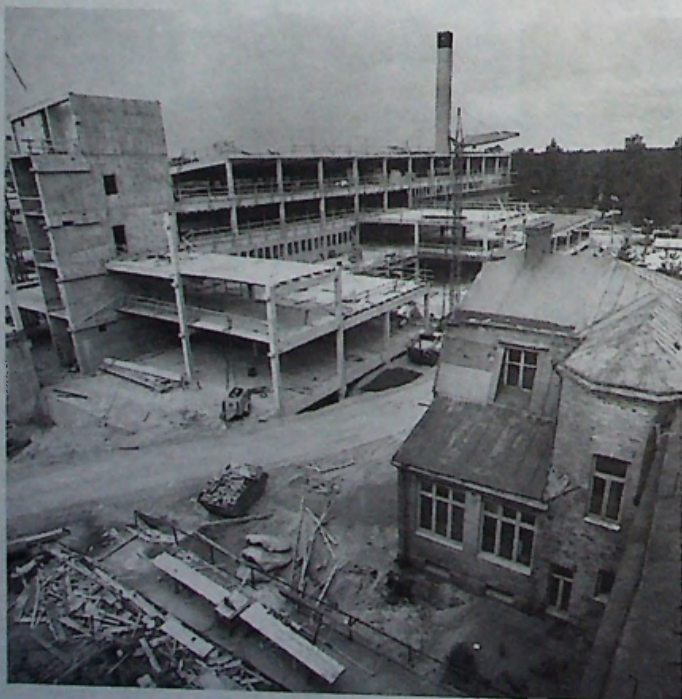
Ett sjukhus är en ständig bygg- och rivningsplats. Här tar den nuvarande huvudentrén form på 1970-talet.
