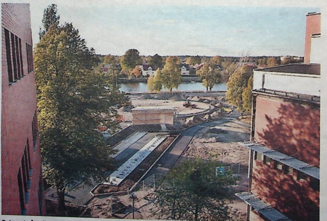
Det mest påtagliga bygget just nu på Centralsjukhuset är helikopterflygplatsen intill Klarälven.
