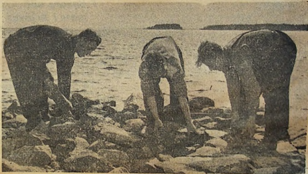
En bastant brygga håller på att byggas vid Skutberget. Här jobbar fr. v. Karl Erik Lundqvist, Jens Lövgren och Erik Svensson med stenarna.
