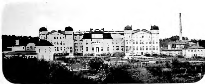
Fot. K. Nystrom.
