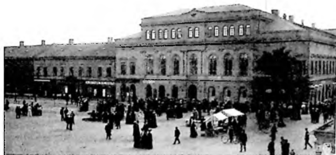
44. Frimurarlogen före ombyggnaden.
