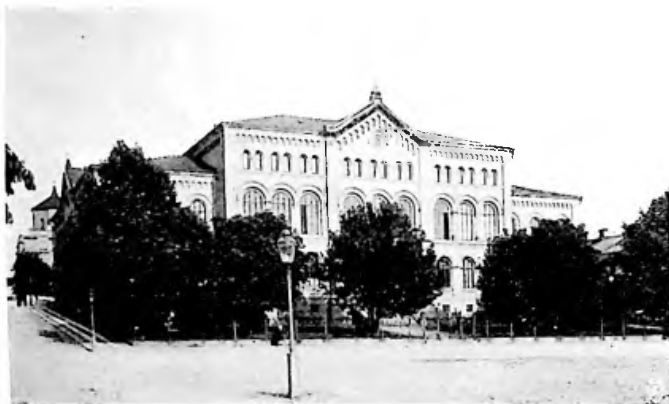
28. Läroverkets år 1868—69 uppförda byggnad.
