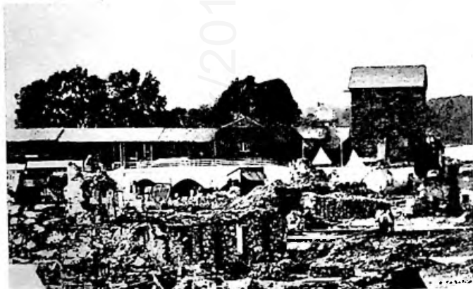
7. Vy öfver vestra bron, magasinerna norrut och stennagasinet. Fot. tagen omedelbart efter branden.
