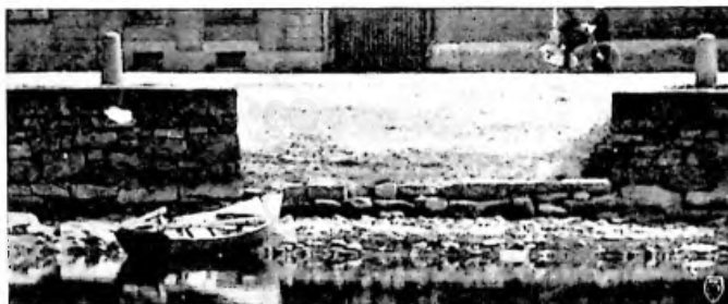
22. En af de två större vattenhämtningsportarne vester om bron.
