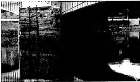
5. En af vestra brons bropelare ofvan strömmen. De gamla förankringarne här förstärkta efter reparation.
