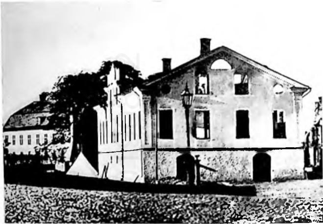
40. Det tillbyggda våghuset efter branden.
